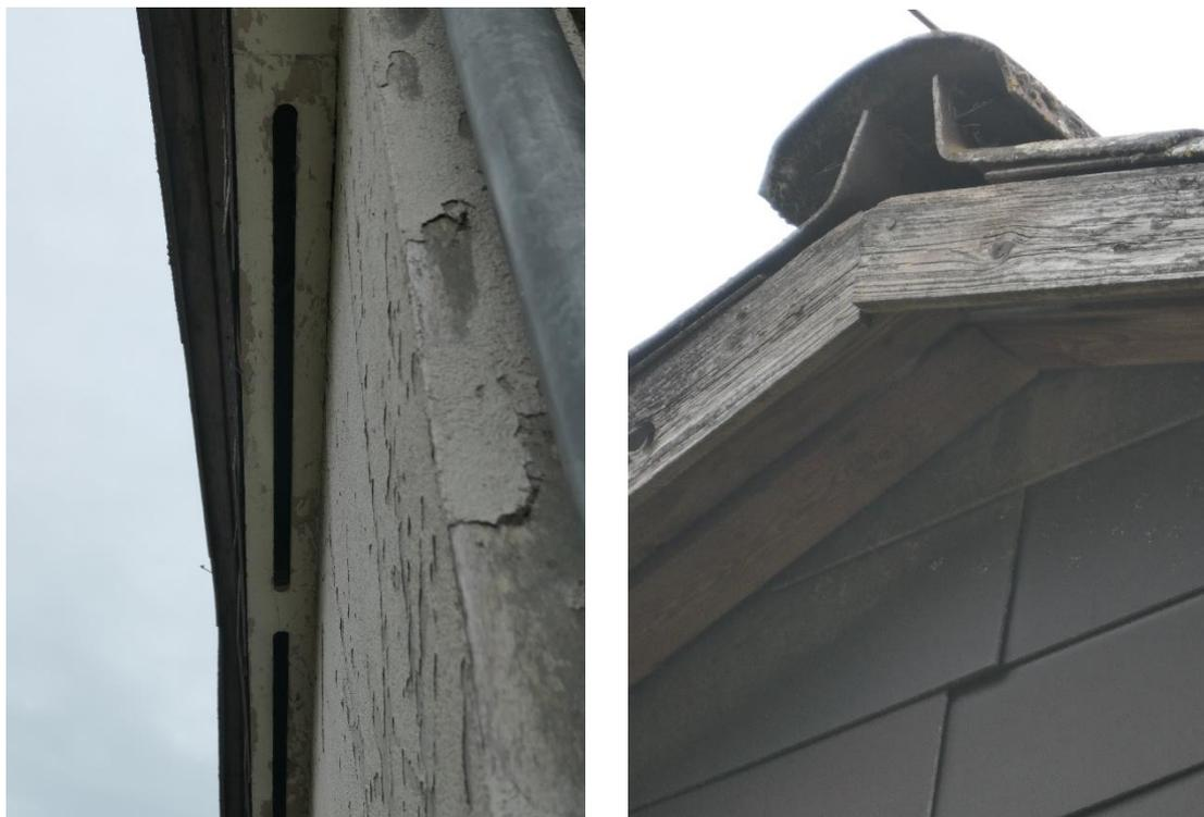
Abb. 8: Öffnungen an der Fassade und am First im Westen des Gebäudes
