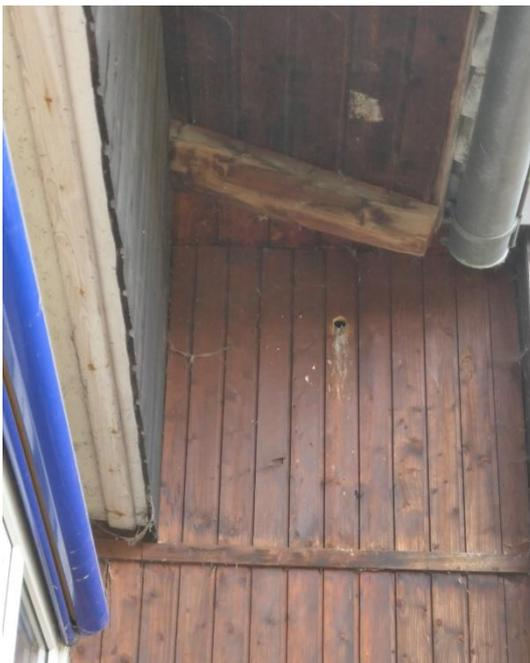
Abb. 6: *Fassadenloch mit Anflugstange und Vogel-Kotspuren im Südwesten des Gebäudes*
