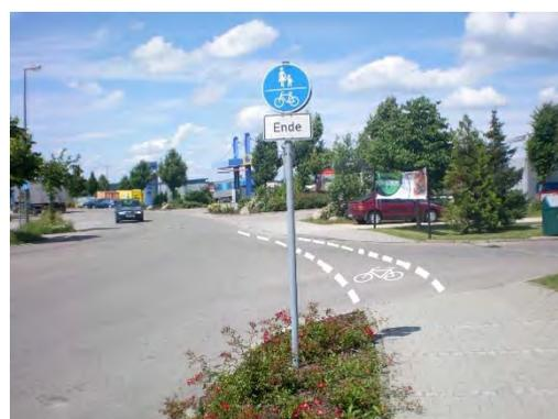
Nachher: Radwegefurt zur Weiterleitung des Radverkehrs auf die Fahrbahn der Rinderhofer Breite
