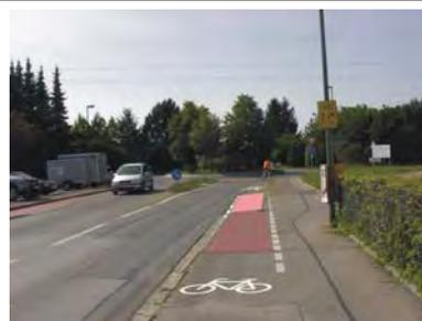
Nachher: Durch Verlängerung der Schutzstreifens sichere Querung ohne zusätzliche Radwegefurt möglich
